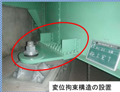
塗装塗り替え・落橋防止装置の設置
