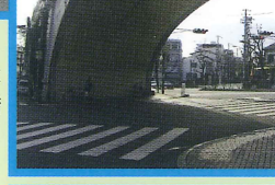
石造の門みたいな阪急の高架橋
