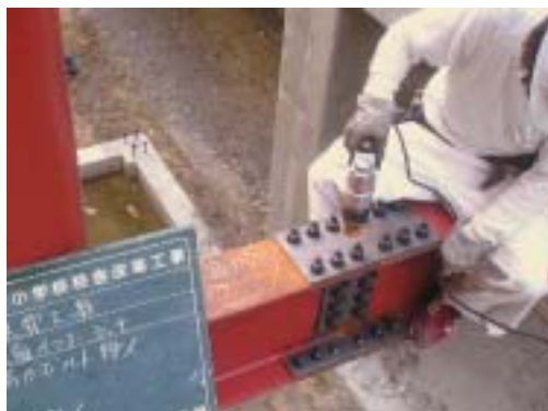
校舎改築工事の高力ボルト締付け作業
