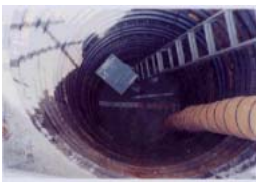
山田町原野地区污水管布設工事（その2）
