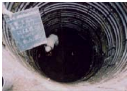
僧尾地区管路施設工事（その4）
