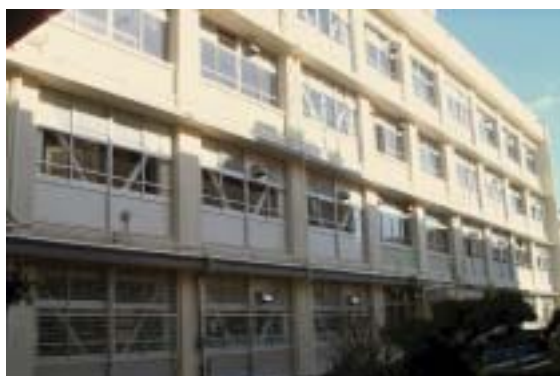
舞子中学校の耐震補強状況
