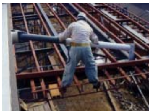
展示場の塗装作業
