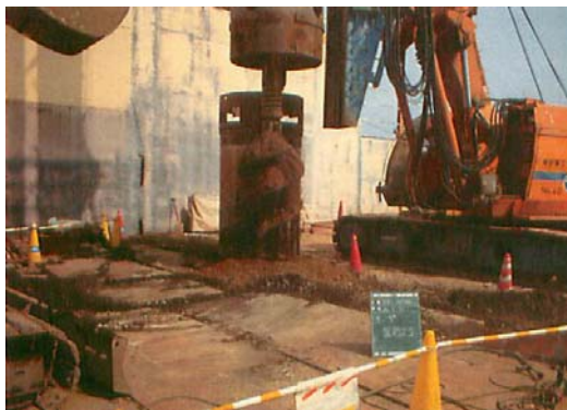
地中障害物探査工（アースオーガー削孔）
