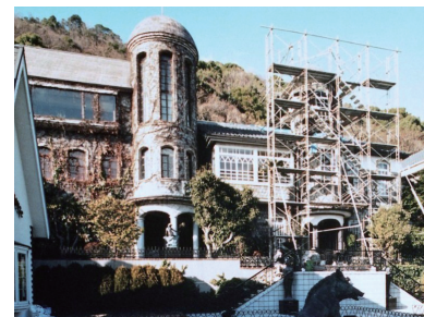
〈異人館修復作業 (うろこの家)〉 写真提供：神戸市
