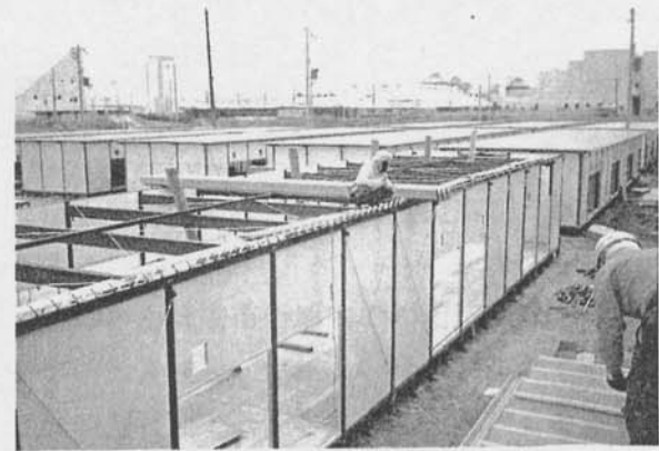
6. 建物建方—先ず鉄骨フレームが生まれ外壁パネル、屋根材、外部建具といった順で建方が進行していく。
