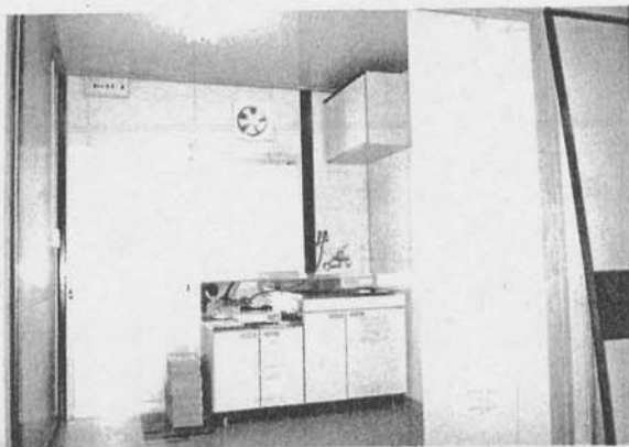
11. 内部完成写真(2)-台所廻りの完成写真。吊戸棚、ガスコンロ(1口)は本工事に含まれる。流し台横に置いてあるコンクリートブロックは洗濯機の置台用として配付した。
