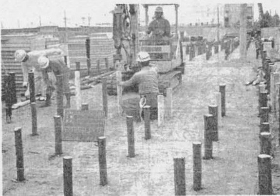
3. 木杭打設—写真のように重機を用いて打設する方法と人力により打設する方法がある。
