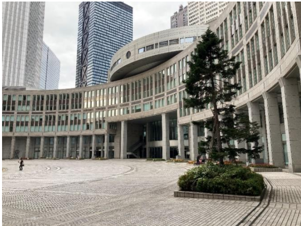
東京都庁舎 都民広場 (平成 2 年（1990 年）竣工)
