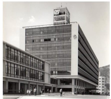
旧2号館・議会棟
